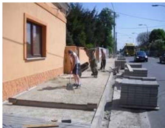
Výstavba chodníka na Komárňanskej ulici
